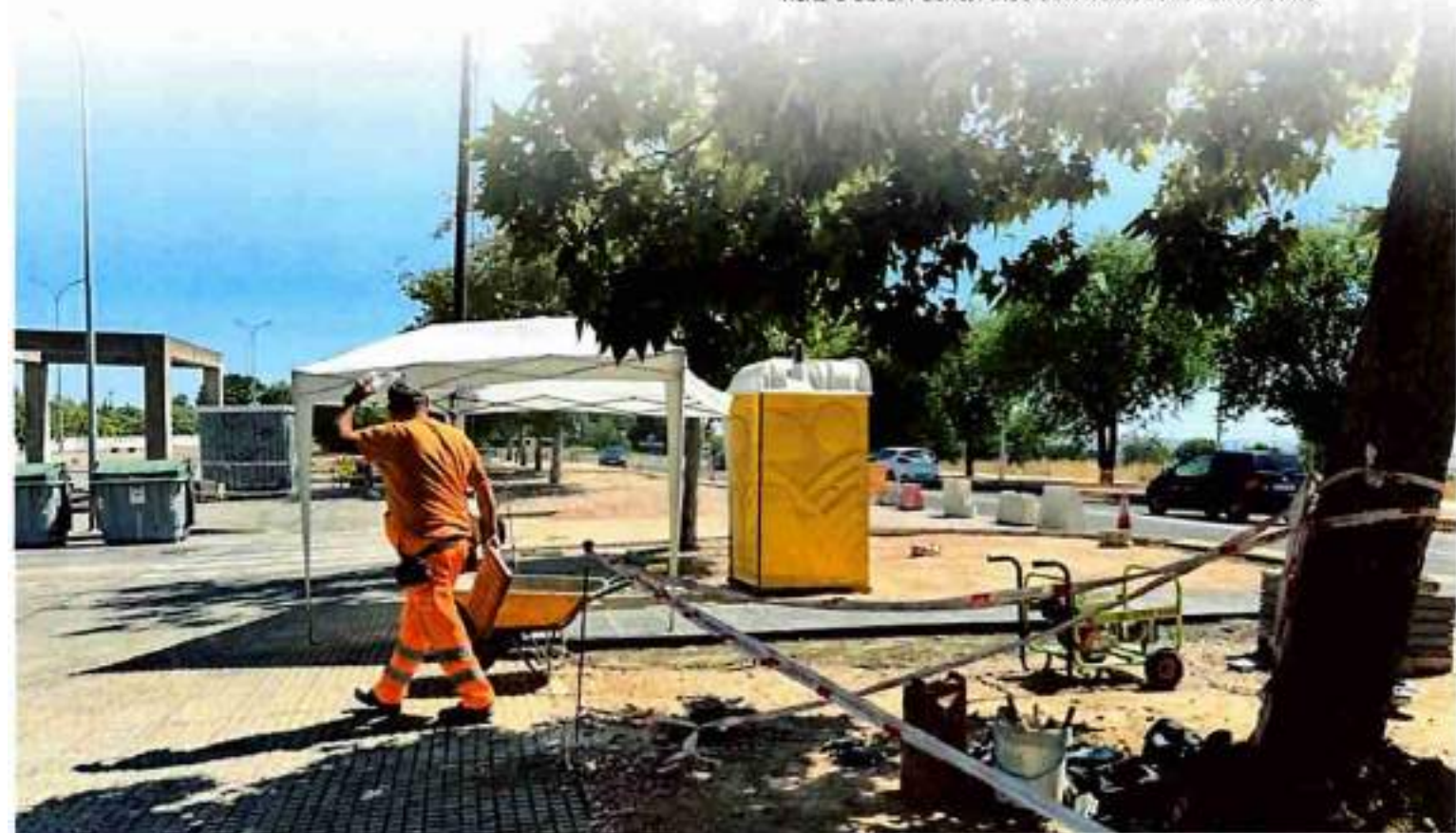
Visita a obra. Fuente: Matilde Vicente. CESSLA Cáceres.
