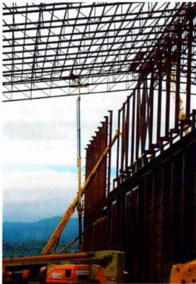
Construcción Foto: Francisco J. Rajo. Técnico PRL CESSLA.
